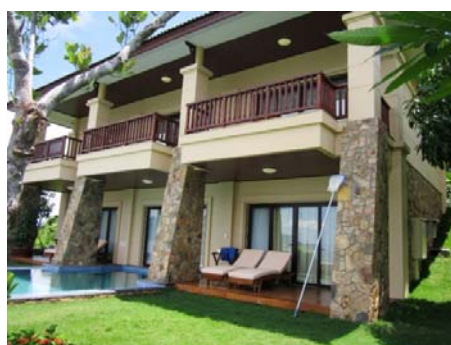
Diềm mái và lang can biệt thự
